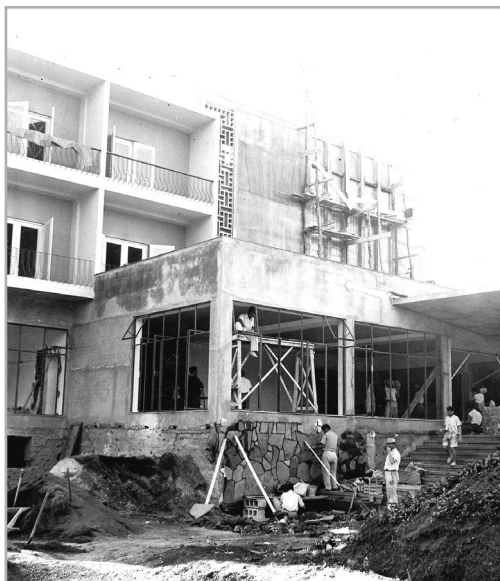
Figura 5 - El hotel Tigaiga en construcción
